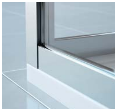
Instalação na base de duche
